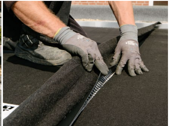
2. Der nächste Abschnitt wird direkt aneinander gelegt. Das schwarze Filtervlies muss dabei überlappen. Wenn nötig, muss die Drainplatte gekürzt werden, um eine ausreichende Überlappung gewährleisten zu können.
