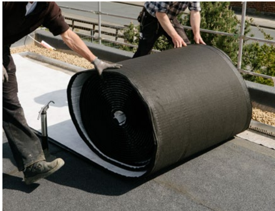
1. Hasse Kombidrain Rolle positionieren, ausrollen und umdrehen. Das schwarze Vlies muss oben sein.
