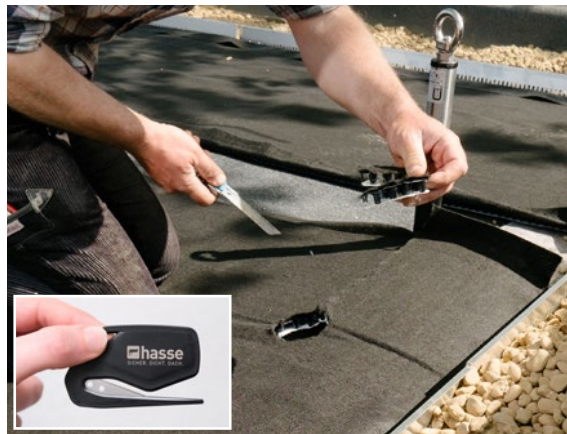
3. Der Zuschnitt von Hasse Kombidrain kann mit einem normalen Messer oder dem speziellen Hasse Messer erfolgen.
