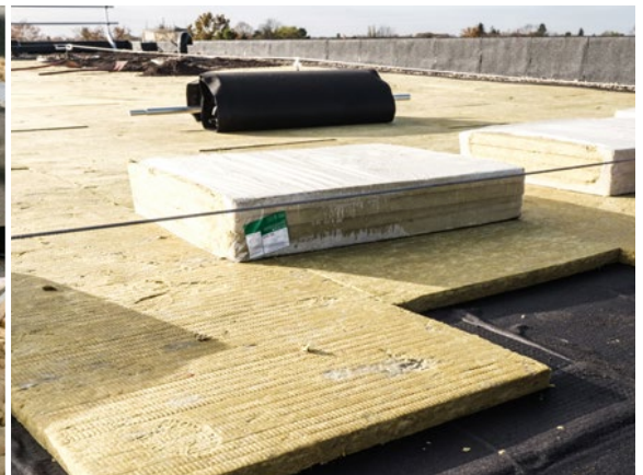
4. Die Hasse Substratmatte wird direkt aneinander und in versetzten Reihen verlegt. Der Zuschnitt kann beispielsweise mit einem Messer oder Fuchsschwanz erfolgen. Vor der Verlegung der Hasse Vegetationsmatte muss die Hasse Substratmatte ausreichend bewässert werden.
