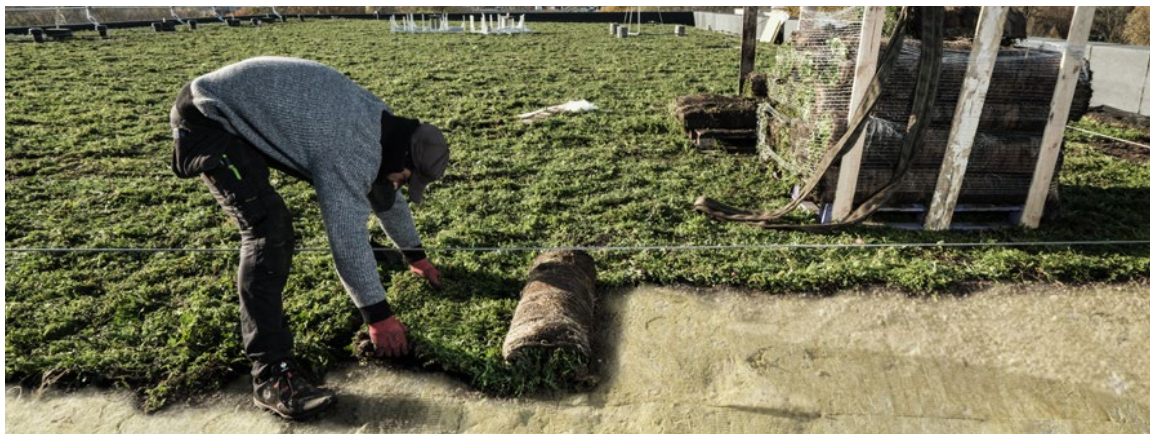
5. Die Hasse Vegetationsmatten sind bei der Verarbeitung schonend zu behandeln. Die Verlegung sollte im versetzten Verband mit ca. 2,5 cm Überlappung erfolgen. Um spätere Rückstellungen zu vermeiden darf kein Zug auf die Hasse Vegetationsmatten ausgeübt werden. Hohlräume und Mulden eventuell mit losem Substrat auffüllen und anschließend die Fläche mit einer Rasenwalze leicht andrücken. Je nach Vegetationsmatte kann eine durchgehende Schicht Substrat nötig sein.
