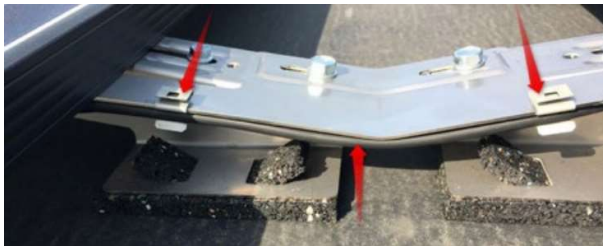
Korrekt befestigte DC-Verkabelung
