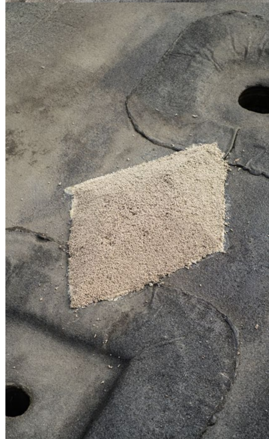
8. HassoForm aushärten lassen (2 bis 3 Stunden)
