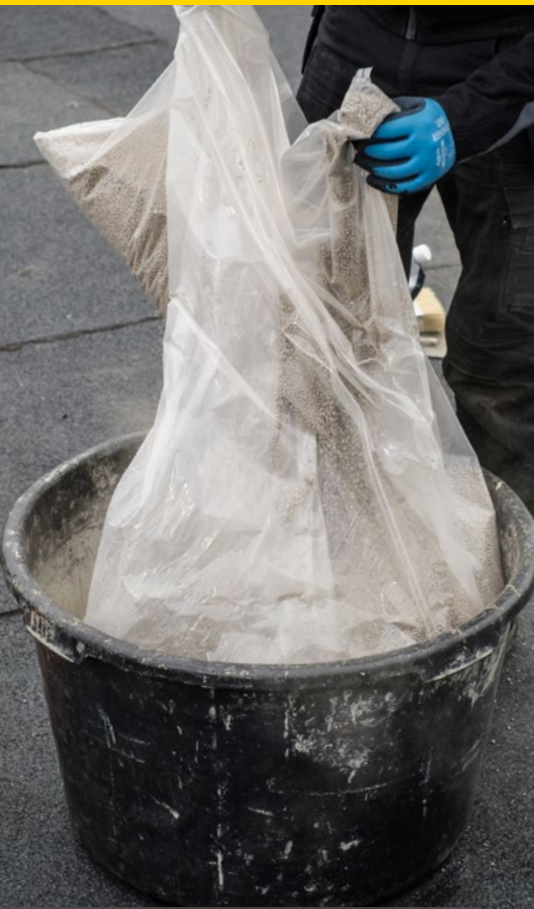
1. HassoForm Schüttung in Rundkübel füllen
