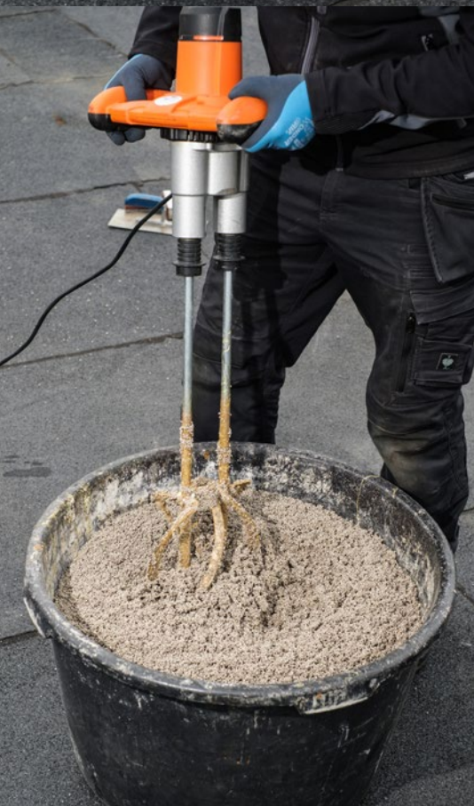
3. Mit Rührgerät vermischen
