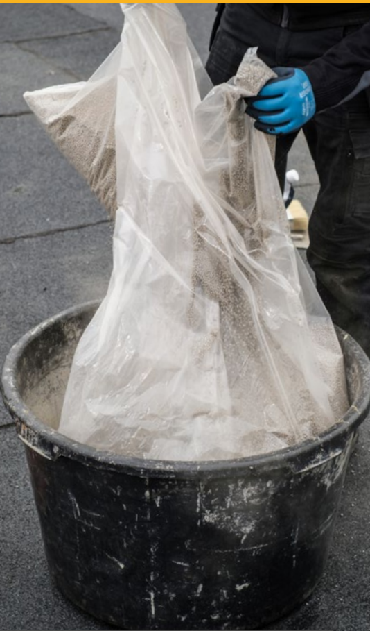
1. HassoForm Schüttung in Rundkübel füllen
