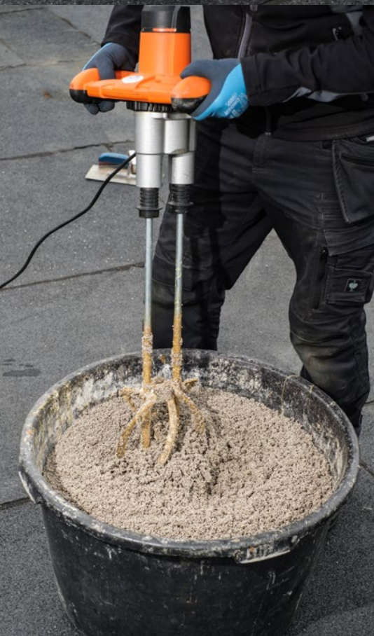
3. Mit Rührgerät vermischen
