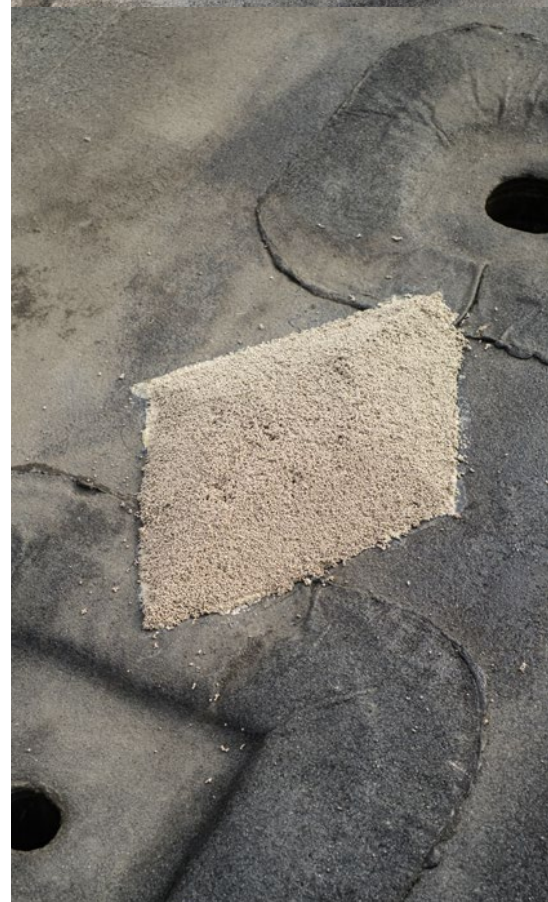
8. HassoForm aushärten lassen (2 bis 3 Stunden)
