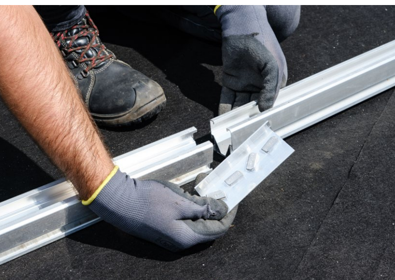
22. Ist ein Verbinden von GSS-Modulmontageschienen notwendig, wird dies mit Hilfe der GSS-Modulmontageschienen-Verbinder umgesetzt.
