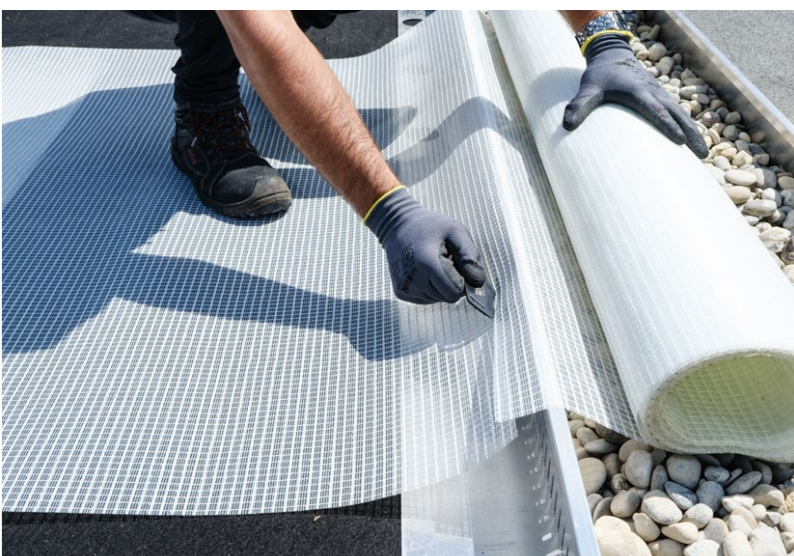
5. An Anfang und Ende einer PV-Modulaufreihung, sowie an Stößen, ist das GSS-Ballastträger-Gewebe mindestens einen Meter herauszuführen sowie einen Meter zu überlappen.
