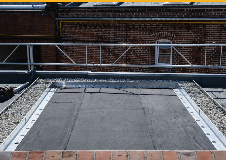
1. Hasse Kombidrain GSS vollflächig auslegen. Siehe dazu auch Verlegeanleitung Hasse Kombidrain auf www.hasse.info
