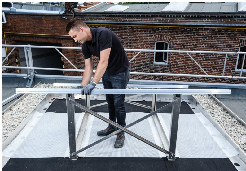
21. GSS-Modulmontageschienen auf kurzer und langer Seite der GSS-Basisträger anbringen.
