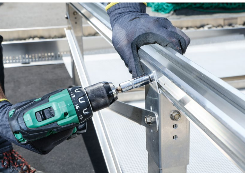
20. Die Hammerkopfschrauben mit einem Drehmoment von 15 Nm festschrauben.
