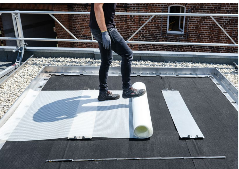
4. GSS-Ballastträger-Gewebe in PV-Modulaufreihung ausrollen. Dabei ist darauf zu achten, dass das Gewebe genau zwischen den Aufkantungen der GSS-Grundplatten läuft.
