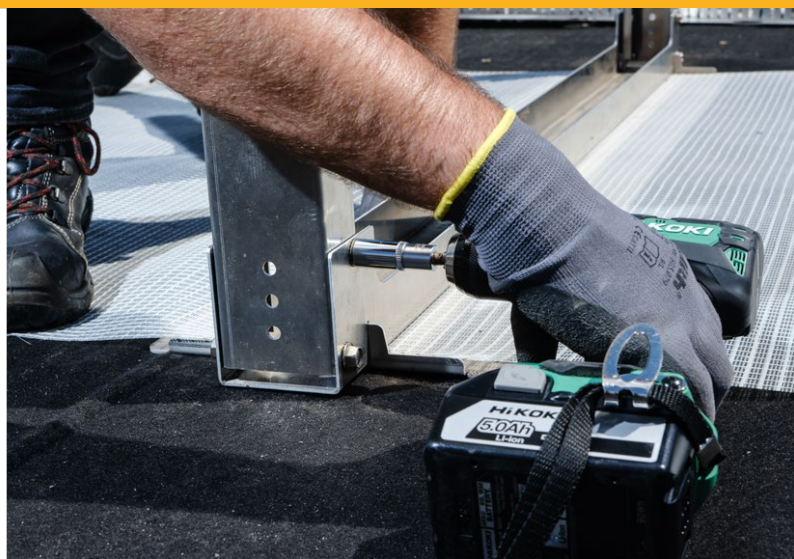
13. Alle Schrauben (4 pro Seite) der aufgestellten Seiten mit einem Drehmoment von 20 Nm anziehen.
