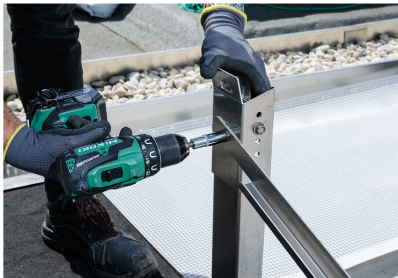
17. Für eine vereinfachte Montage eines GSS-Windverbands sind mehrere Löcher in den GSS-Basisträgern vorgebohrt. Alle Schrauben mit einem Drehmoment von 20 Nm festschrauben.
