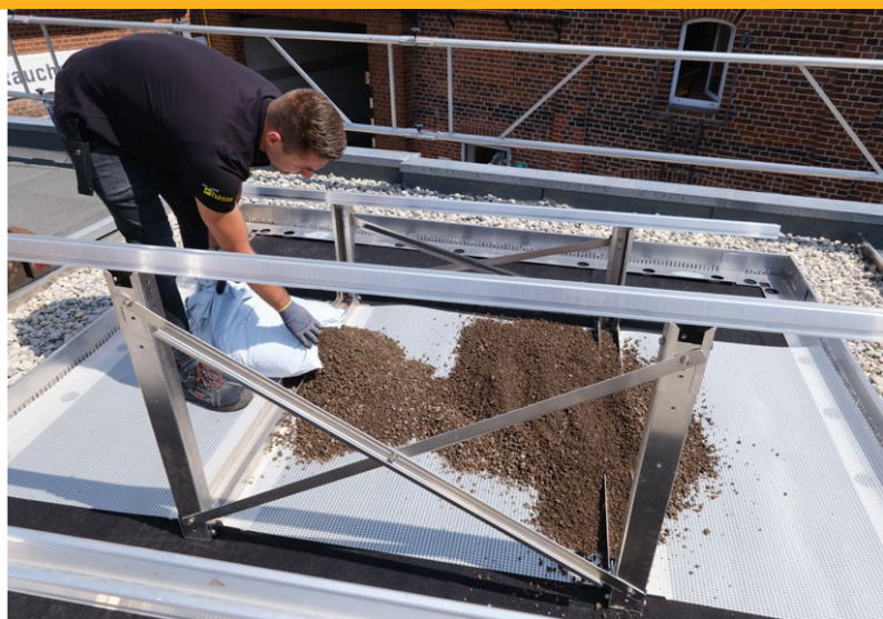
25. GSS-Extensivsubstrat mit vorgegebener Schichtdicke flächendeckend auf GSS-Ballasträger-Gewebe und auf Hasse Kombidrain GSS aufbringen.
