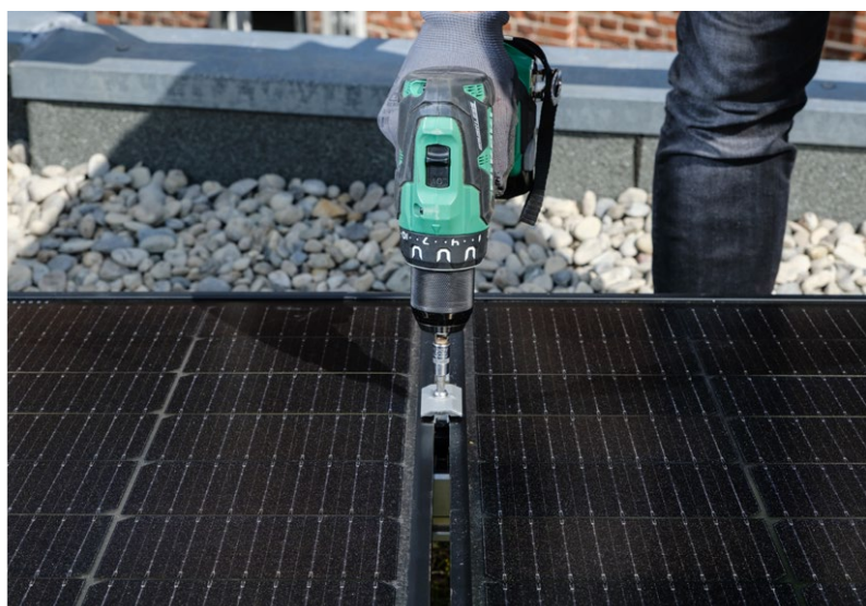
29. Befestigung der PV-Module mit GSS-Modulmittelklemme. Schrauben mit 6-7 Nm Drehmoment festschrauben.
