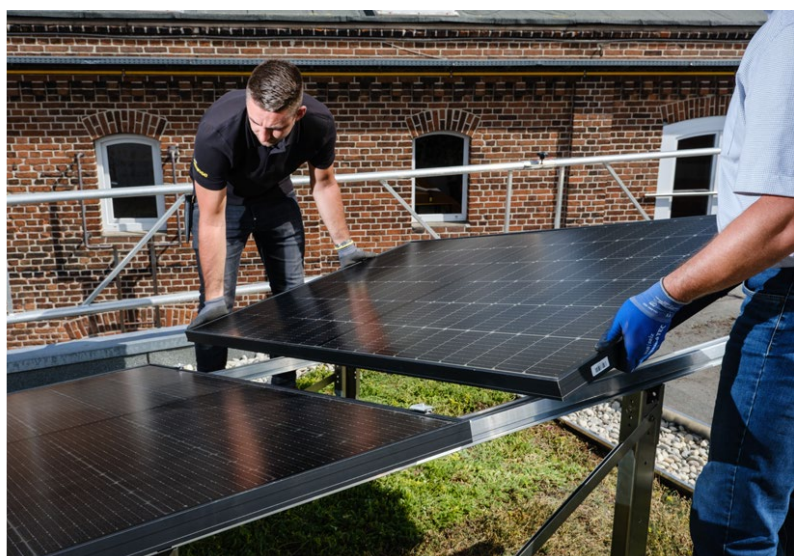
27. PV-Module, beginnend an einem Ende einer Reihe, auf GSS-Modulmontageschienen installieren.
