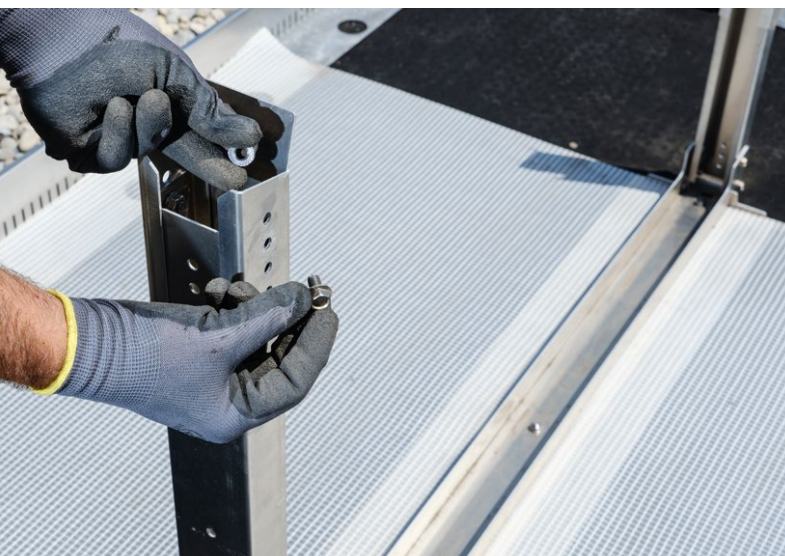
14. Höhe der GSS-Basisträger mit Höhenjustierungen anpassen, um ggf. Unebenheiten oder Gefälle auszugleichen. Schrauben mit einem Drehmoment von 20 Nm festschrauben.
