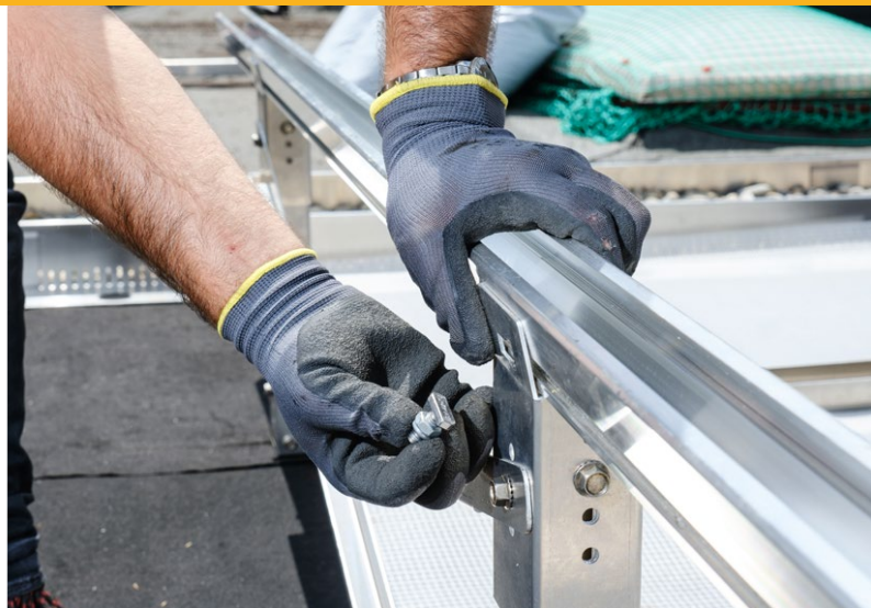
19. Mittels Hammerkopfschrauben die GSS-Modulmontageschienen an den GSS-Basisträgern fixieren.
