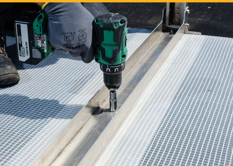
12. Die Muttern der GSS-Grundplatte mit einem Drehmoment von 20 Nm festschrauben.
