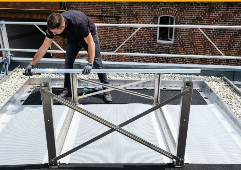
18. GSS-Modulmontageschienen mittig über GSS-Basisträger ausrichten.
