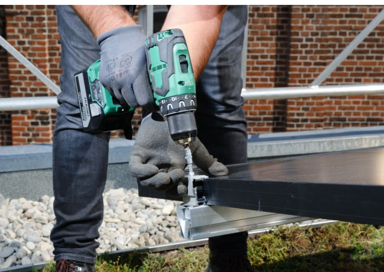
28. Befestigung der PV-Module mit GSS-Modulendklemme. Schrauben mit 6-7 Nm Drehmoment festschrauben.
