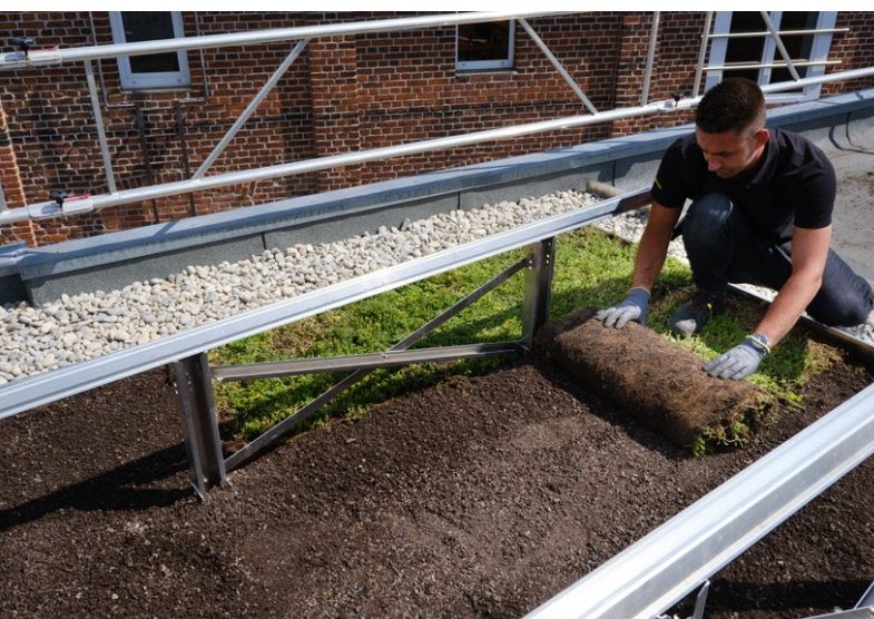
26. GSS-Vegetationsmatten vollflächig auf GSS-Extensivsubstrat auslegen. Der Zuschnitt der GSS-Vegetationsmatten erfolgt mit einem Messer mit langer Klinge.
