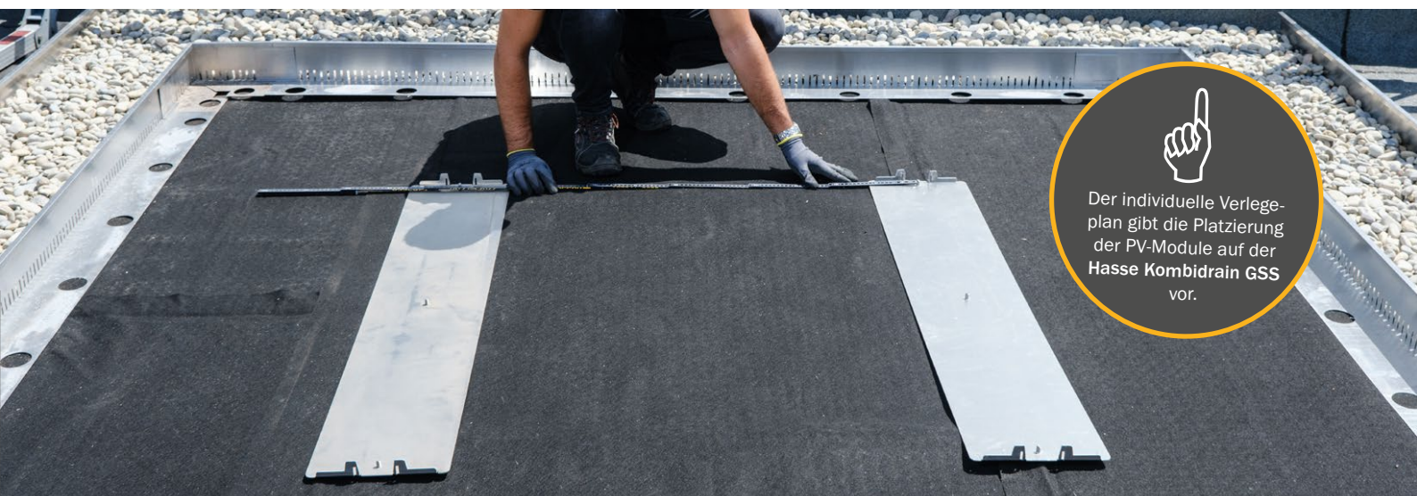
3. GSS-Grundplatten mit Verschraubung nach oben auf Hasse Kombidrain GSS legen. Der Abstand zwischen GSS-Grundplatten in einer PV-Modulaufreihung ergibt sich wie folgt: PV-Modulbreite+Modulklemmenbreite.
