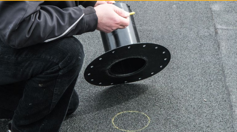
1. Markierung mit Radius vom Diffusionslüfter auf Bestandsfläche
