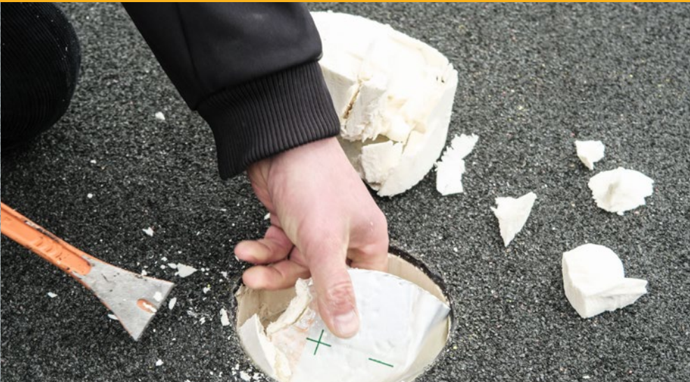
2. Abdichtungslagen und Wärmedämmung entfernen (Dampfsperre belassen!)
