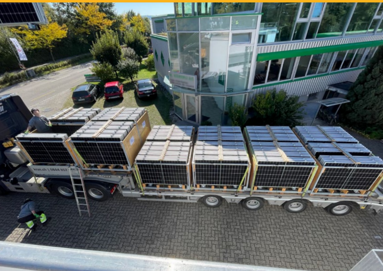
1. Anlieferung der vormontierten PV-Module.
