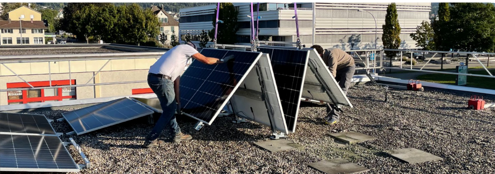
3. Leichte Positionierung nach einem vorab festgelegten Verlegeplan. Hier zu sehen mit Kies als schweren Oberflächenschutz.
