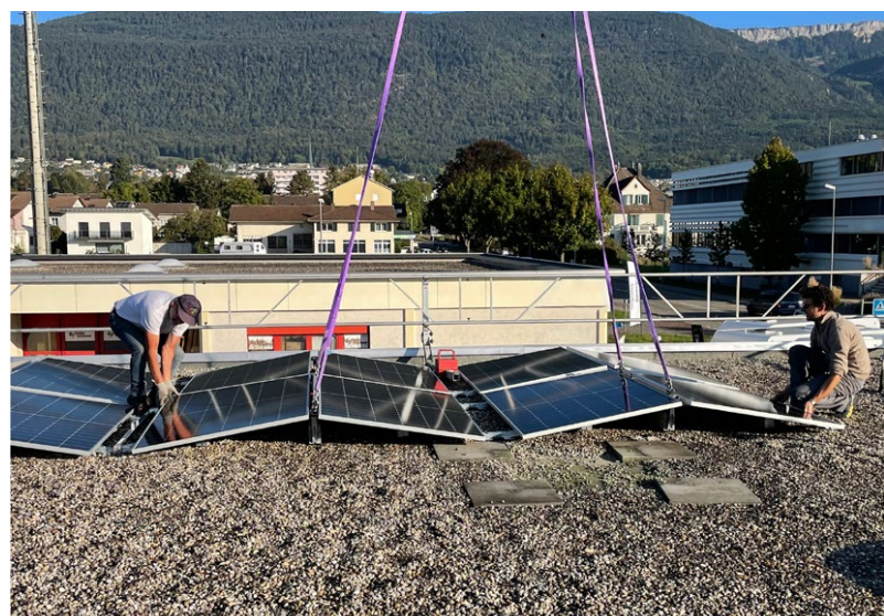
4. Ein 3-Personen-Montageteam kann an einem Tag bis zu 180 kWp installieren – inklusive Anschluss auf der Gleichstromseite.
