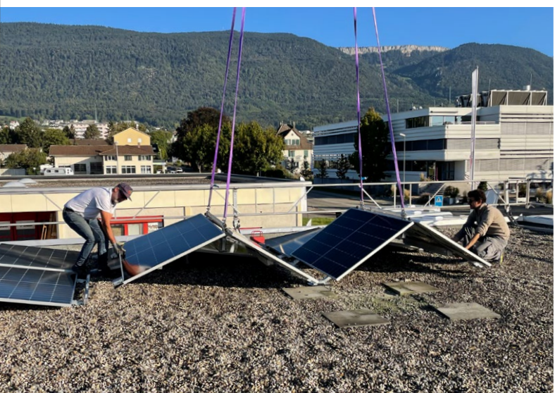
4. Ein 3-Personen-Montageteam kann an einem Tag bis zu 180 kWp installieren – inklusive Anschluss auf der Gleichstromseite.
