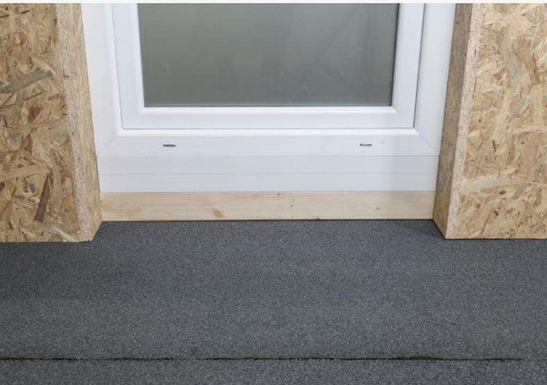
1. Anschlussarbeiten auf bituminöser Oberlagsbahn beschiefert, OSB 3/4, Massivholz trocken und PVC-Fensterprofil.
