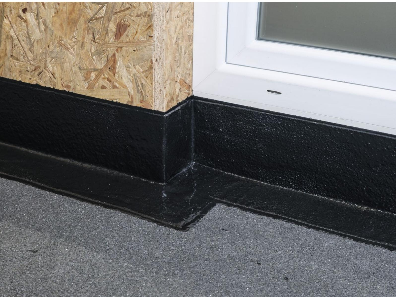
14. Die fertige Oberfläche ist nach ca. 45 Minuten regenfest und bei entsprechender Temperatur und Luftfeuchte nach ca. 24 Stunden durchgetrocknet.
