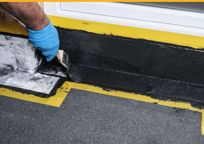
12. Die Deckschicht mit 1/3 Hassolit 1K ECO (mind. 0,9 kg/m<sup>2</sup>) auftragen, Lufteinschlüsse austreichen und gleichmäßig verteilen.
