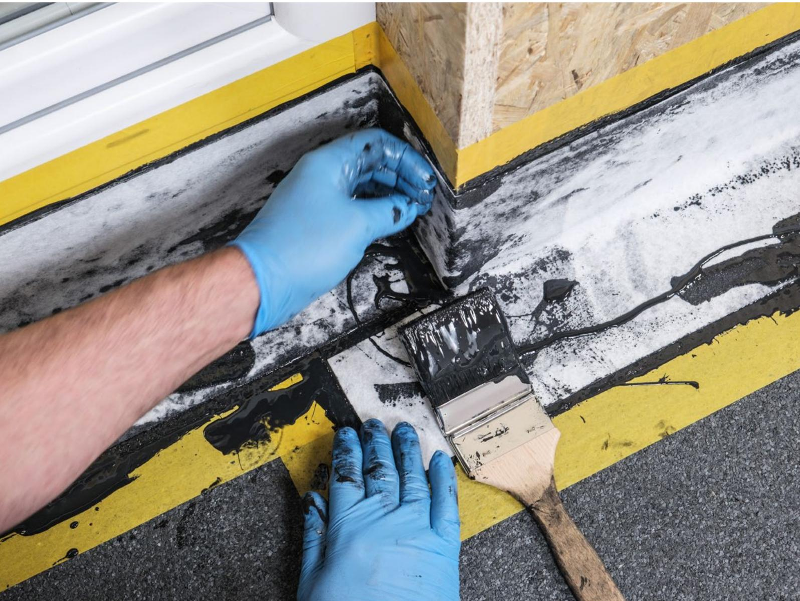
11. Dort, wo keine vorgefertigten Vlies-Eckteile eingesetzt werden können, wird das Vlies zuvor so eingeschnitten, dass die Überlappung von Vlies zu Vlies mind. 5 cm beträgt. Die Überlappungen der Vliese müssen mit Hassolit 1K ECO flächendeckend (es dürfen keine weißen Vlies-Stellen im Überlappungsbereich mehr sichtbar sein) untereinander verklebt werden.
