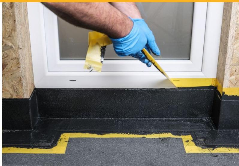
13. Beim waagrecht verklebtem Kreppband aufpassen, dass kein überschüssiger Flüssigkunststoff vom Kreppband neben der Fläche vorbei läuft.
