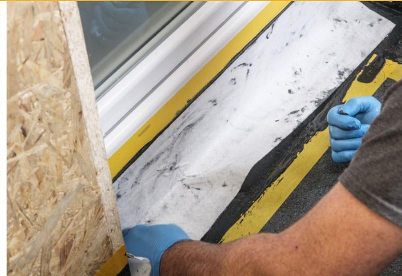
10. Das zuvor trocken angepasste Vlies in das vorgelegte Material blasen- und faltenfrei einlegen und leicht andrücken.
