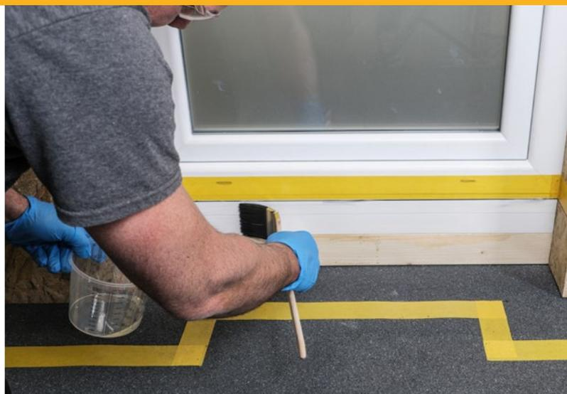
5. Die gereinigte und geschliffene Oberfläche des PVC Fensterprofils mit Hassolit 1K Grundierung ECO einstreichen. Trocknungszeit laut Produktdatenblatt beachten.
