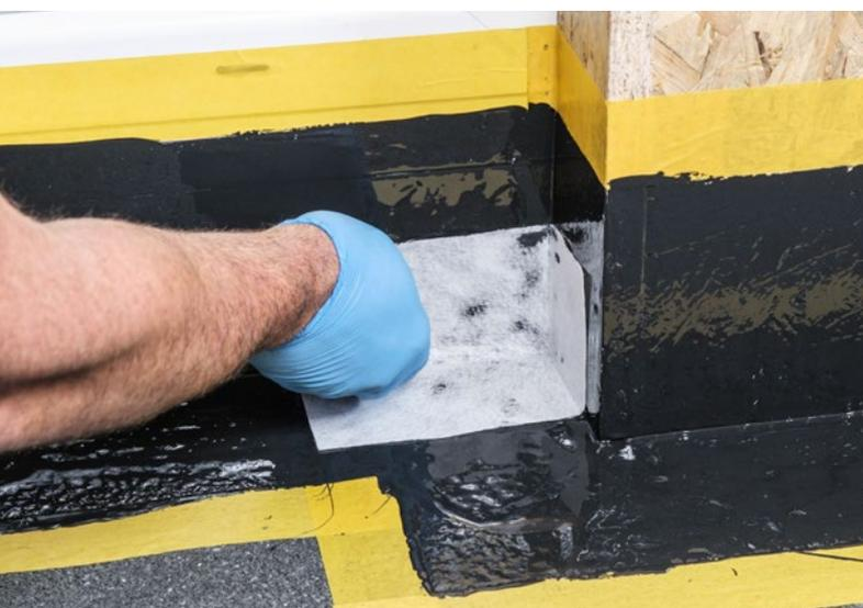
7. Das Vlies in das vorgelegte Material blasen- und faltenfrei einlegen und leicht andrücken. Hier: vorgefertigte Innenecke.
