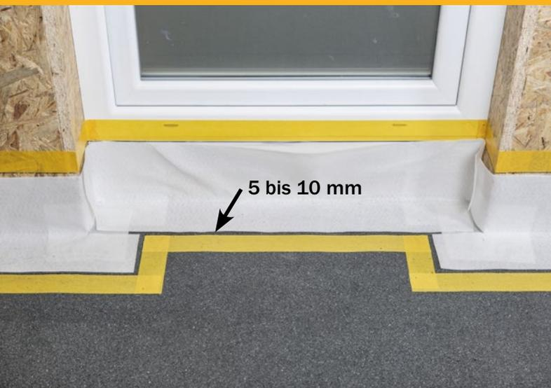
4. Mit Kreppband entlang der Markierung gerade abkleben. Anschließend das Vlies zuschneiden und trocken anpassen, so dass der Flüssigkunststoff 5 bis 10 mm über das Vlies hinausragt wird.
