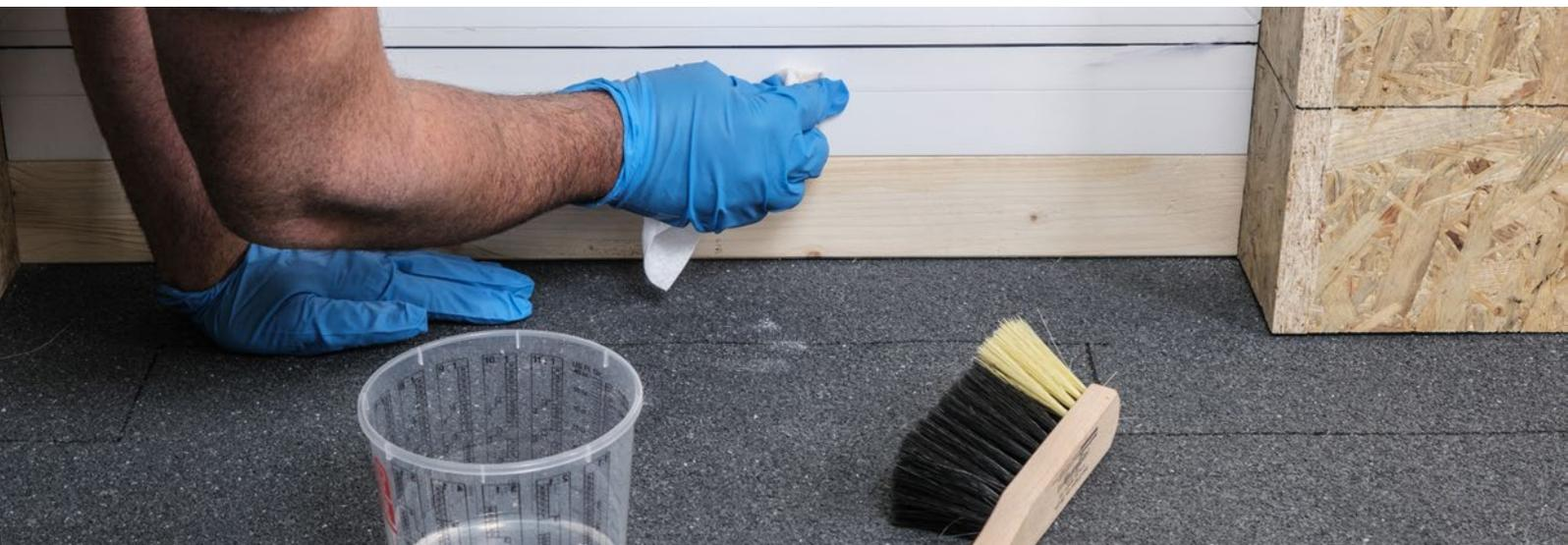
3. PVC Fensterprofil – nach Anweisung aus der Tabelle „Grundierungshinweise“ – mit Hassolit FK Reiniger gründlich säubern. Es dürfen auf allen zu behandelnden Flächen keine Unebenheiten verbleiben. Anschließend die gereinigte Oberfläche im gesamten Anschlussbereich maschinell mit 60er Schleifpapier lückenlos stark anschleifen. Danach Oberfläche mit einem sauberen Handfeger entstauben.
