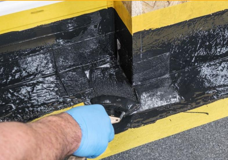
9. Die Deckschicht mit 1/3 Hassolit 1K ECO (mind. 0,9 kg/m<sup>2</sup>) auftragen und beim Einpinseln darauf achten, dass das Vlies nicht verrutscht. Lufteinschlüsse mit dem Pinsel ausstreichen.
